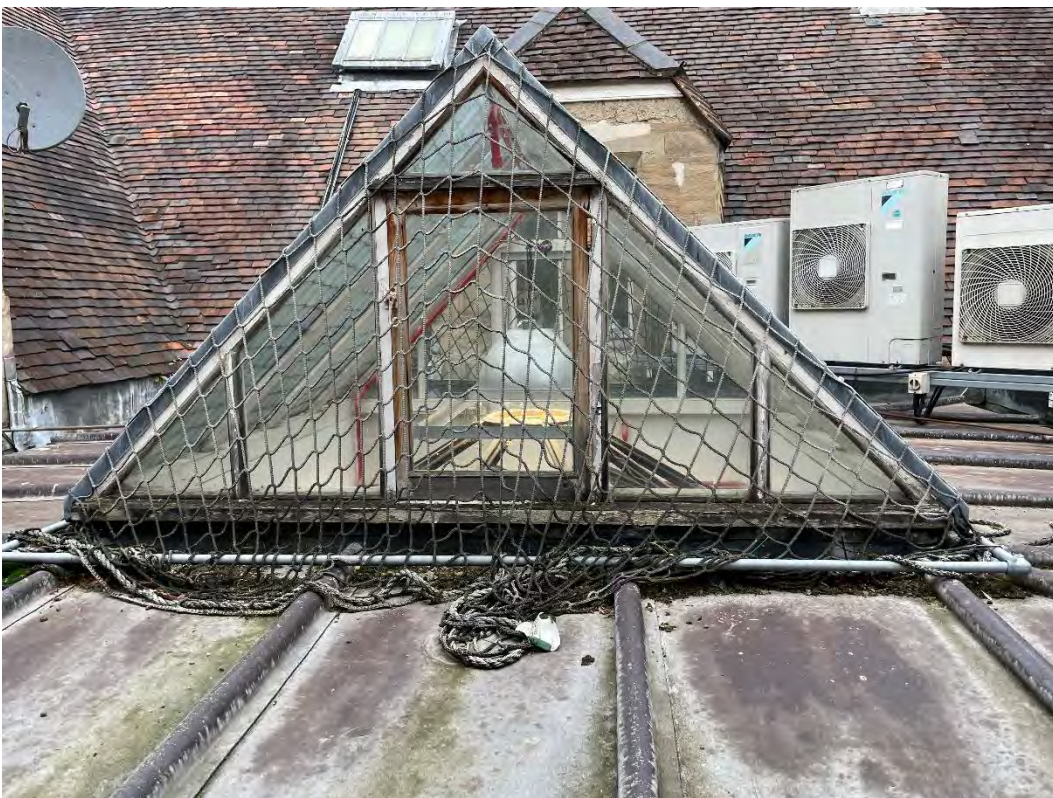
1008) Central flat roof lantern
